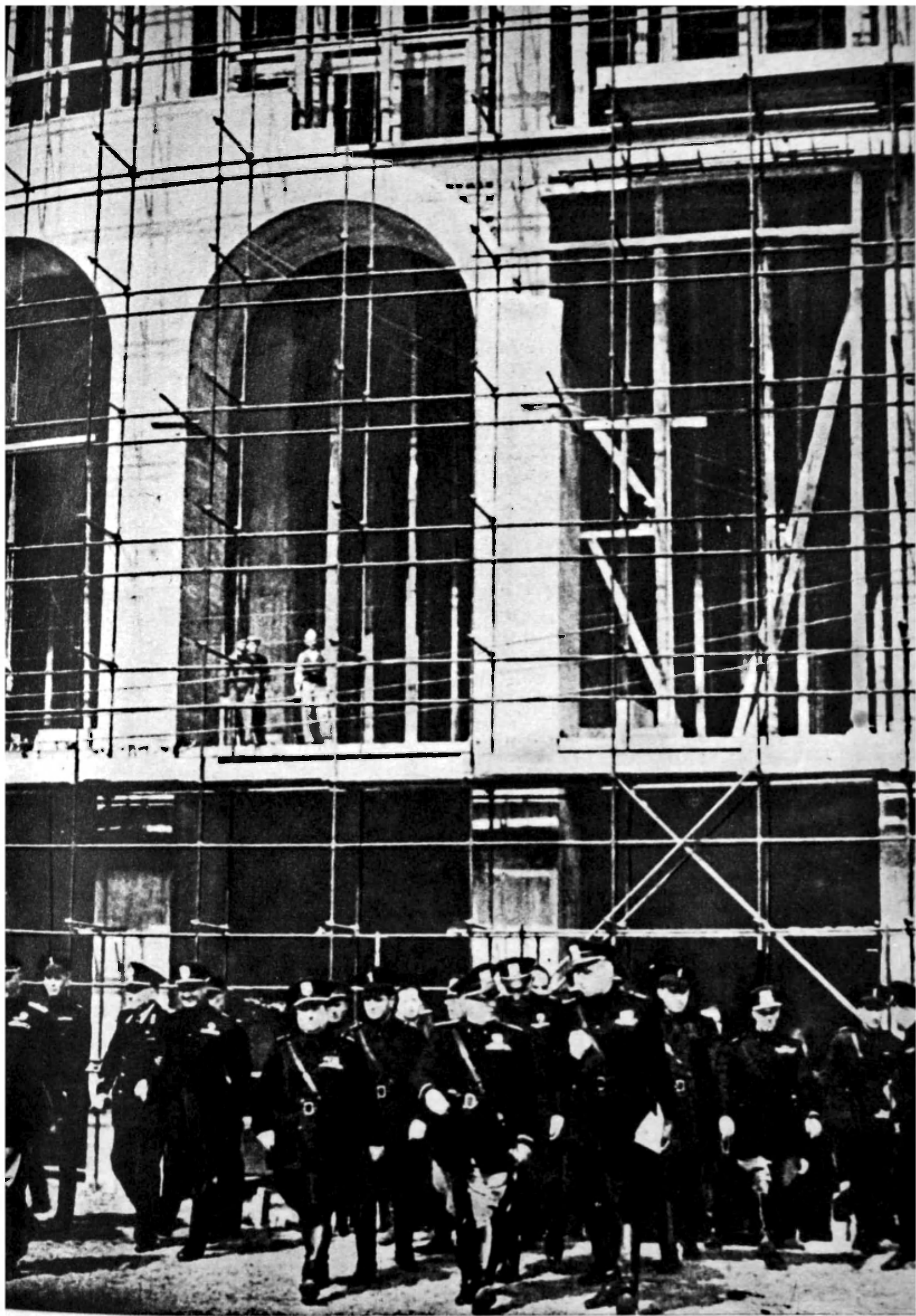
Visita agli edifici in costruzione per l' E 42.
