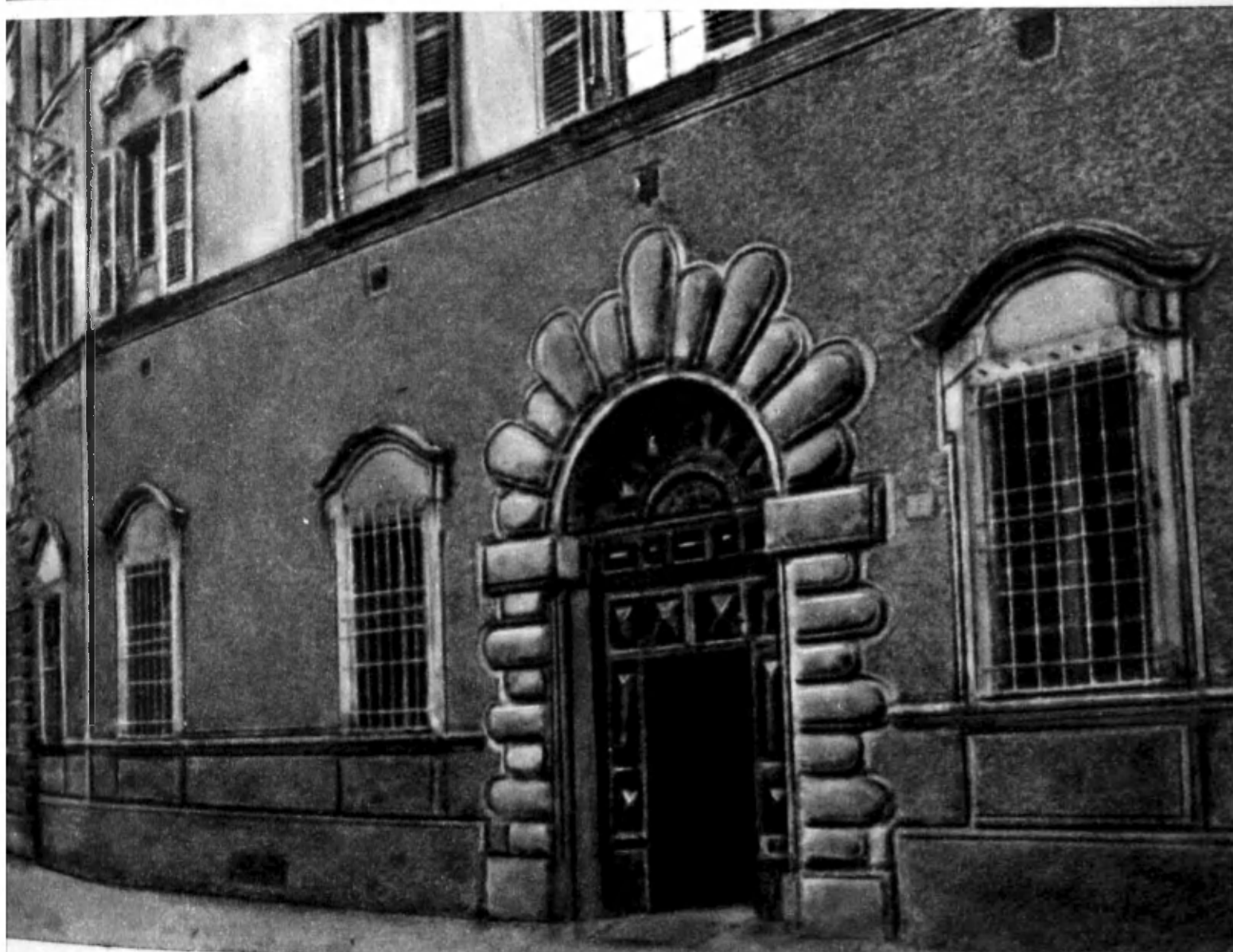
Sopra: La vigna di Cuclon, Sotto: Ingresso del collegio salesiano a Faenza.
